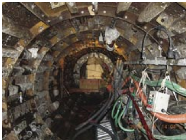
地盤改良作業
