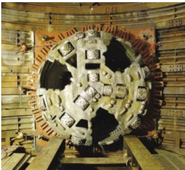
中間立坑に到達したシールドマシン
