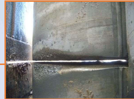
PIP杭切断線
