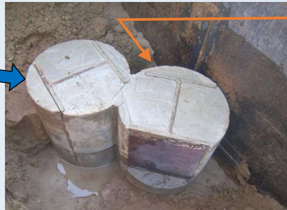
PIP杭切断面
