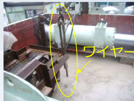
写真-2 切断噴射状況
