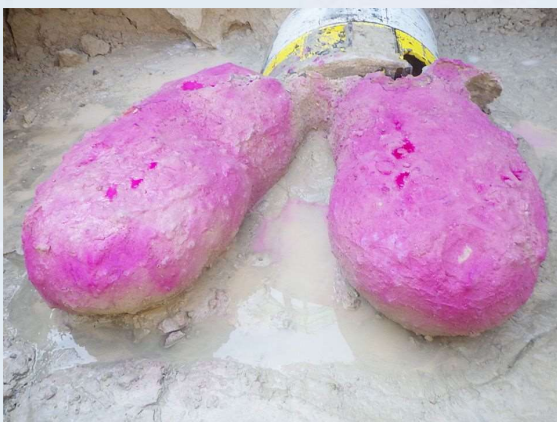
写真-1 セメント系地盤改良
